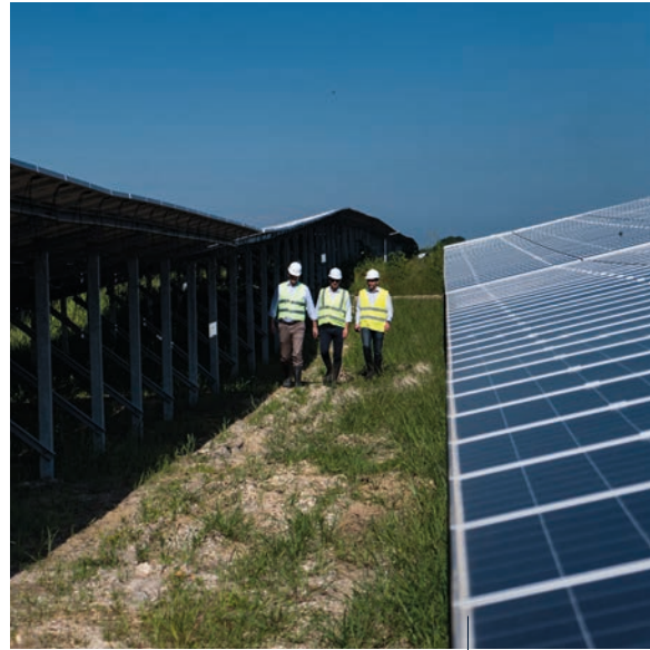
BEIM BAU DER SOLARANLAGE PARADISE PARK, JAMAICA
